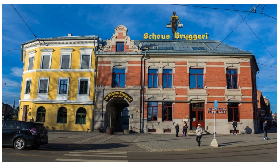
Antigua fábrica de cerveza Schou al inicio de la calle Trondheim, frente al río.
