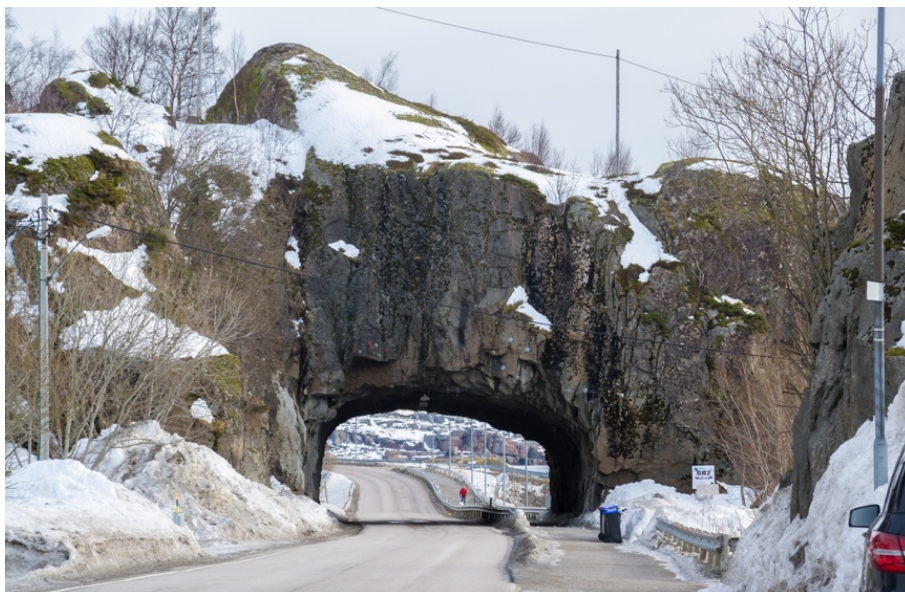
Túnel a la entrada de la ciudad.
